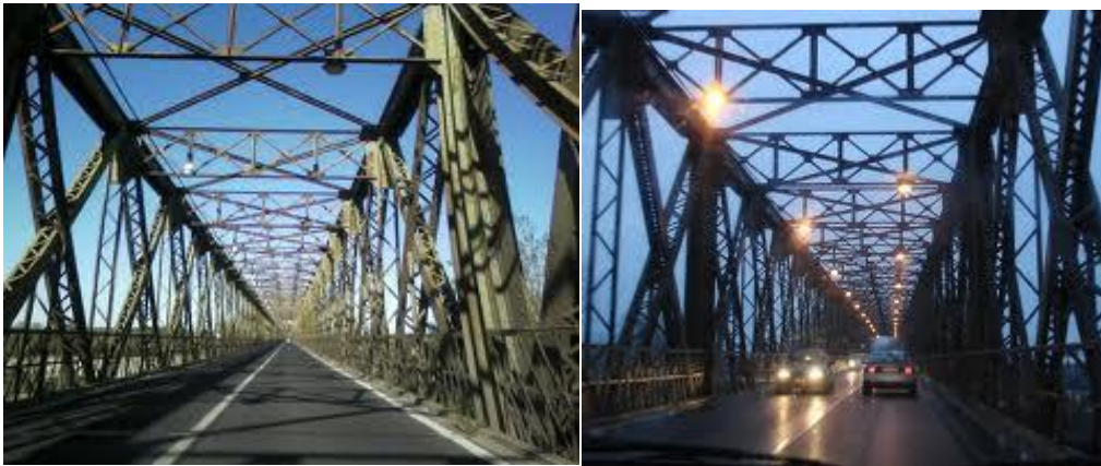
Vista del manto stradale diurna e notturna
